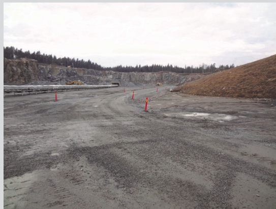
Väg för tung trafik i Skanskas bergtäkt i Olunda. Vägen belastas med ca 1 000 ton per dag.
