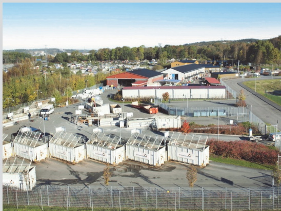
Hela planen för Kretsloppsparken Alelyckan består av betongkross från Skanska (foto: Julia Sjöberg).
