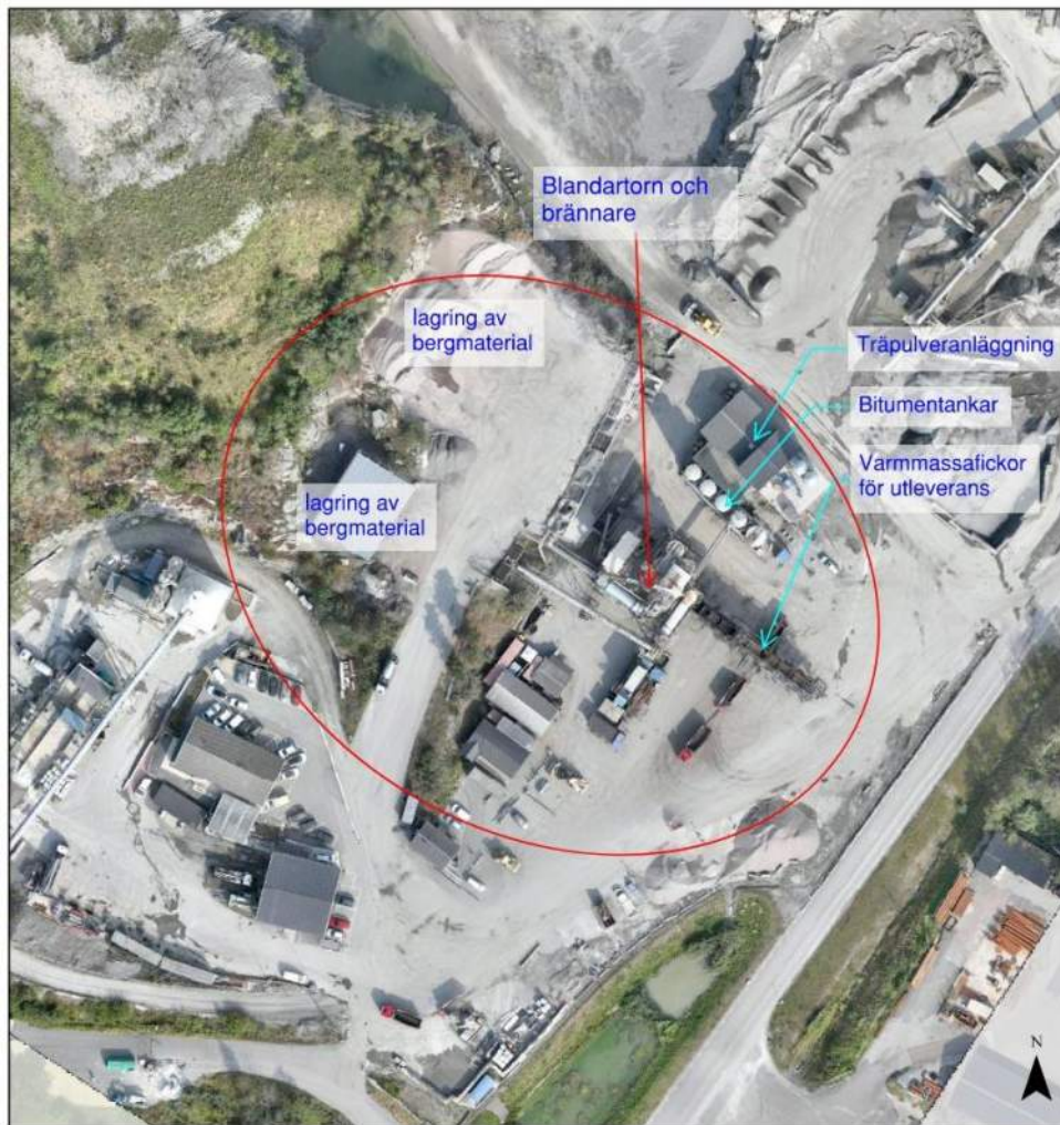
Figur 2.6.1 Översiktsbild, Vikans asfaltverk.
