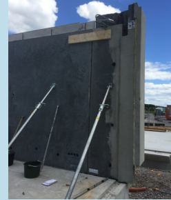
Väggstöd vid prefabmontage
