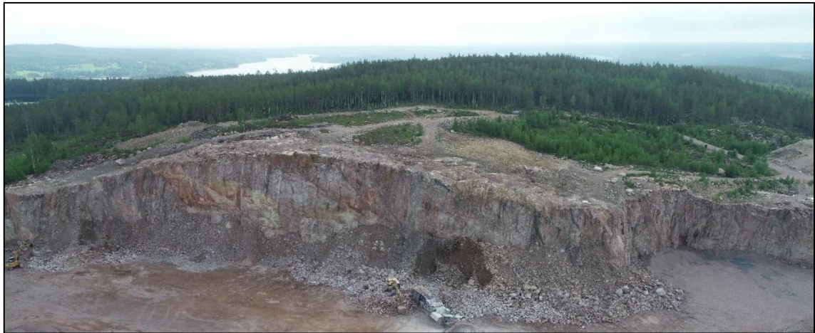
Figur 3.3.1. Foto av skärning vid södra bergväggen vid bergtäkten i Kyrkberget. På bilden framgår den relativt homogena karaktären på berggrunden i området.
