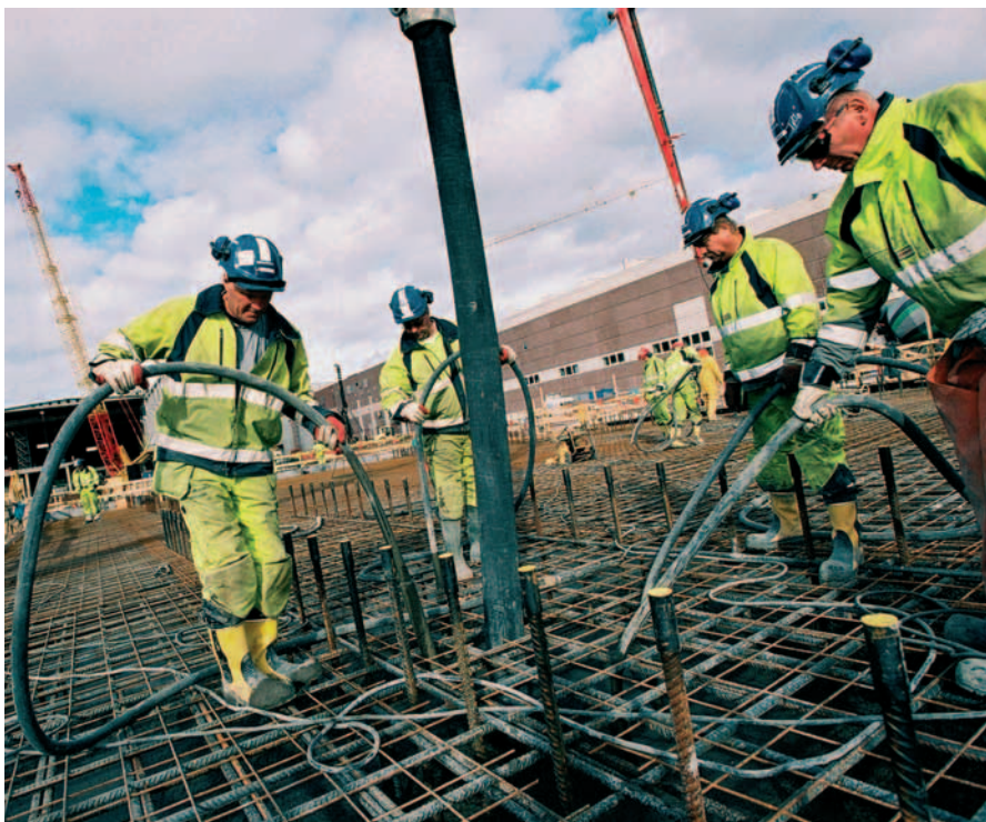
Gjutning med traditionell betong och vibrostavar.
