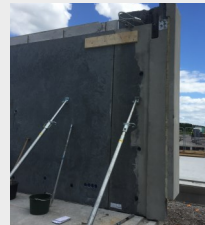
Väggstöd vid prefabmontage
